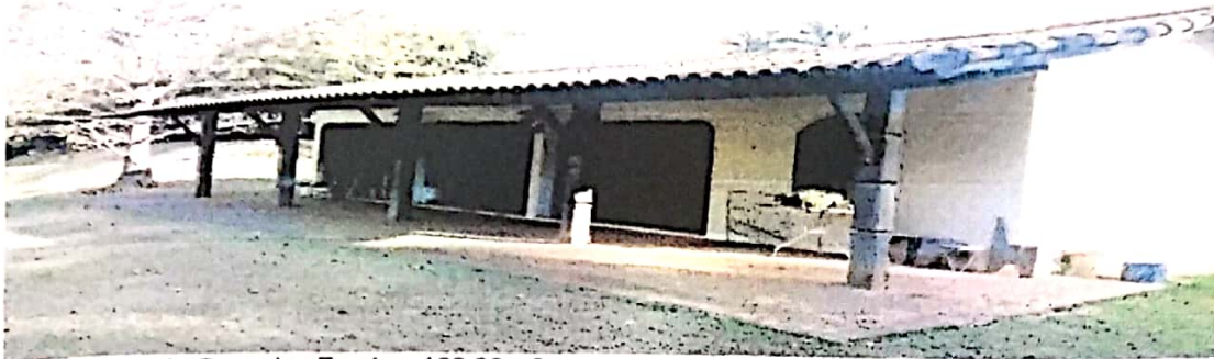
(8) Garagem da Casa dos Fundos 100,00 m 2
